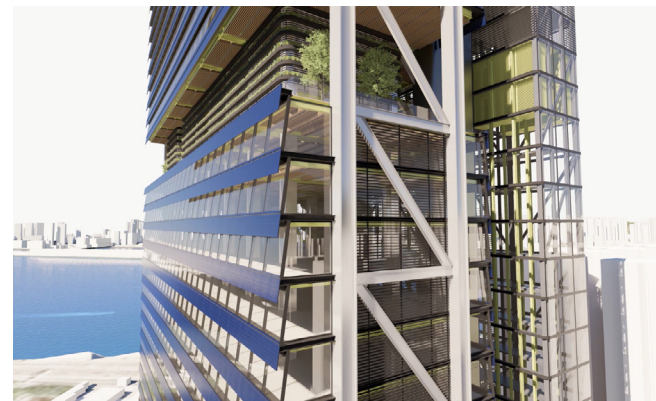
↑ 西立面设计有悬挑, 为工作场所提供最大的遮阳, 而同时, 工作场所面向太阳, 最大限度地利用光伏电池板捕捉阳光, 并让人们可以欣赏西侧的景色。
